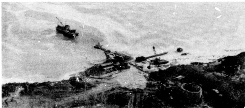
Construction de l'usine de filtration de Matagami.
