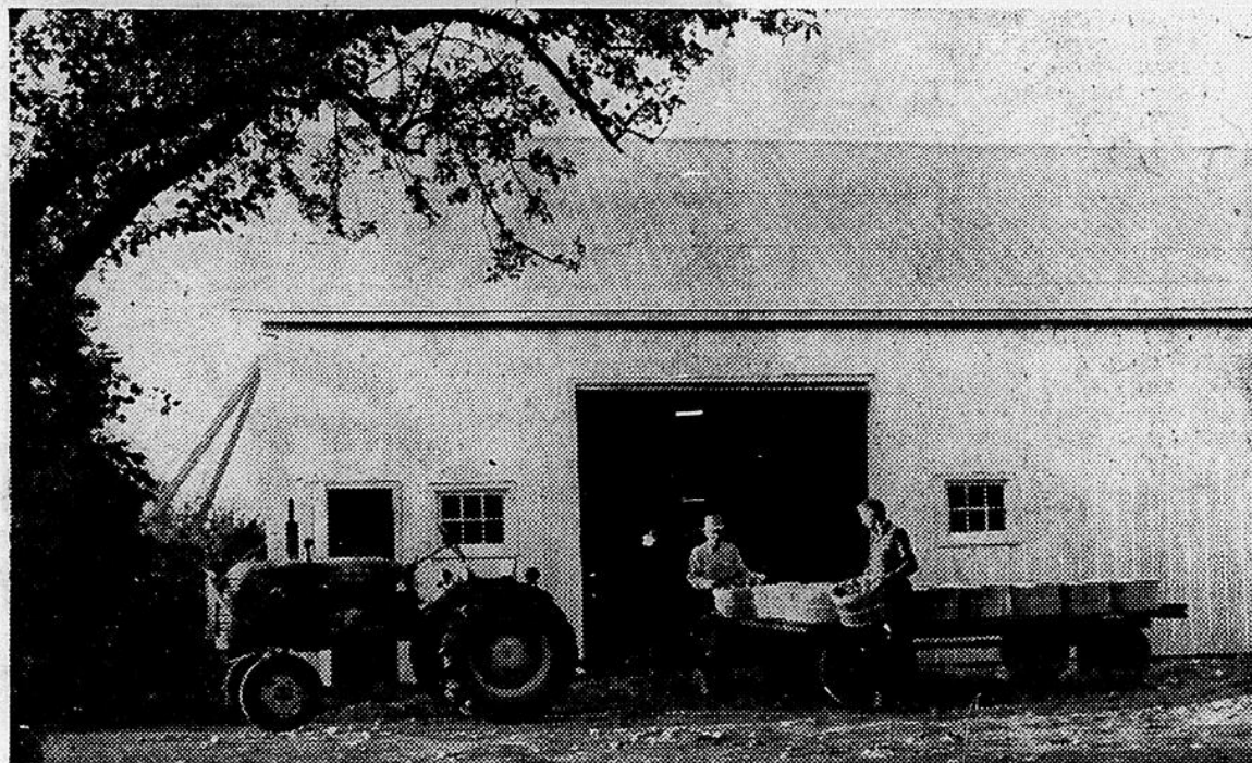
L'année dernière a été marquée par une grosse saison de pommes. Des entrepôts frigorifiques privés, comme celui-ci, sur la propriété de Mel Hall, près de Brockville, ont aidé à prévenir un envahissement soudain des marchés.
