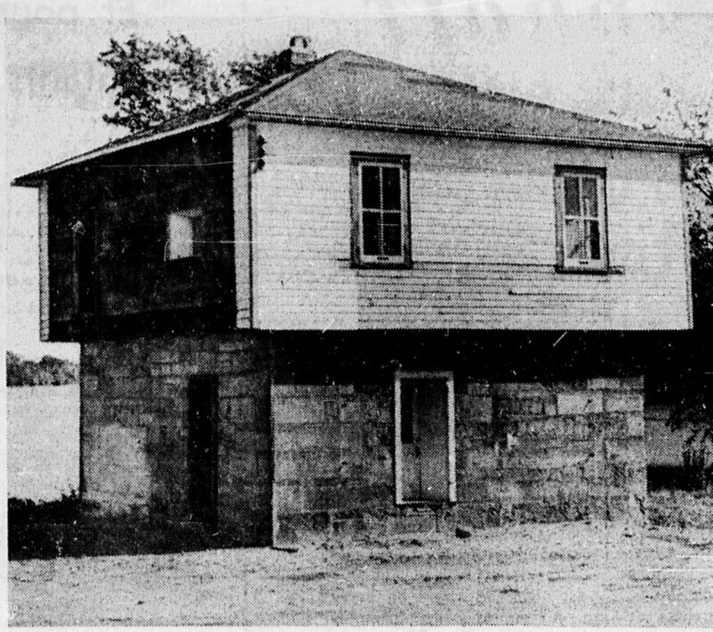
LES TRAVAUX VONT bon train en vue de la restauration de l'ancien blockhaus situé sur le canal Rideau à l'écluse Narrows, entre le lac Rideau supérieur et le grand lac Rideau. Comme ce fut le cas de plusieurs bâtiments du même genre construits lors de l'aménagement du canal il y a plus d'un siècle, on avait ajouté un étage pour loger le personnel du canal. On est en train de rétablir l'aspect original; le bâtiment comprendra le bureau et l'entrepôt du maître-écluseur et des salles de toilette à la disposition des voyageurs en bateau qui empruntent le canal.
