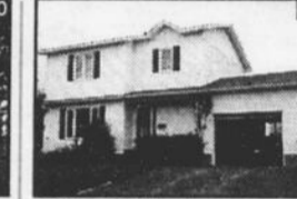
Cottage 3 chambres, garage, Warwick.
