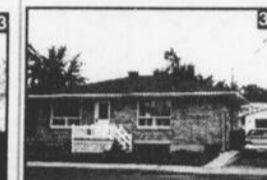
Bung., garage, 2 ch., bonne valeur.
