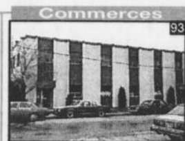
Edifice commercial, centre-ville.
