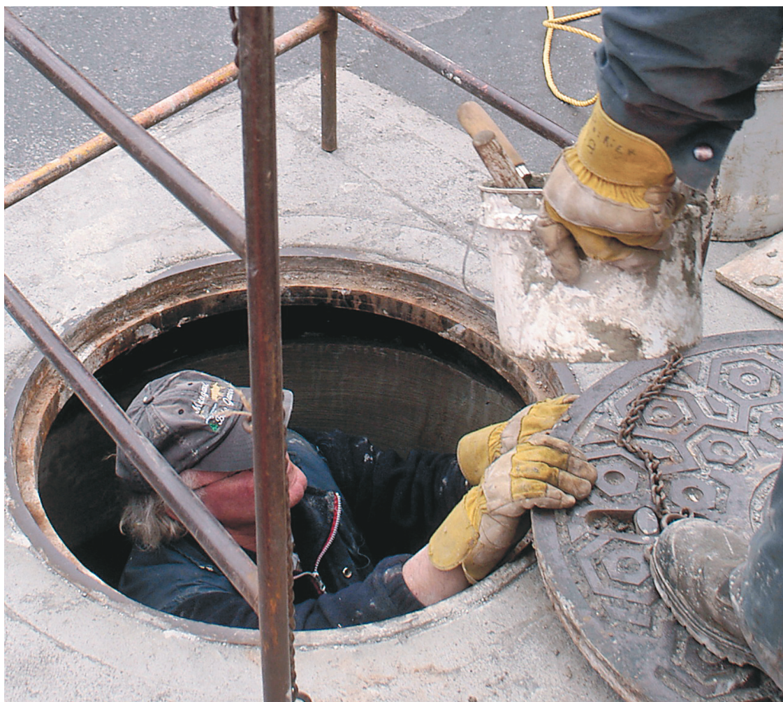
La Ville avait octroyé à la firme un contrat pour la gestion du chantier de réfection des égouts.
