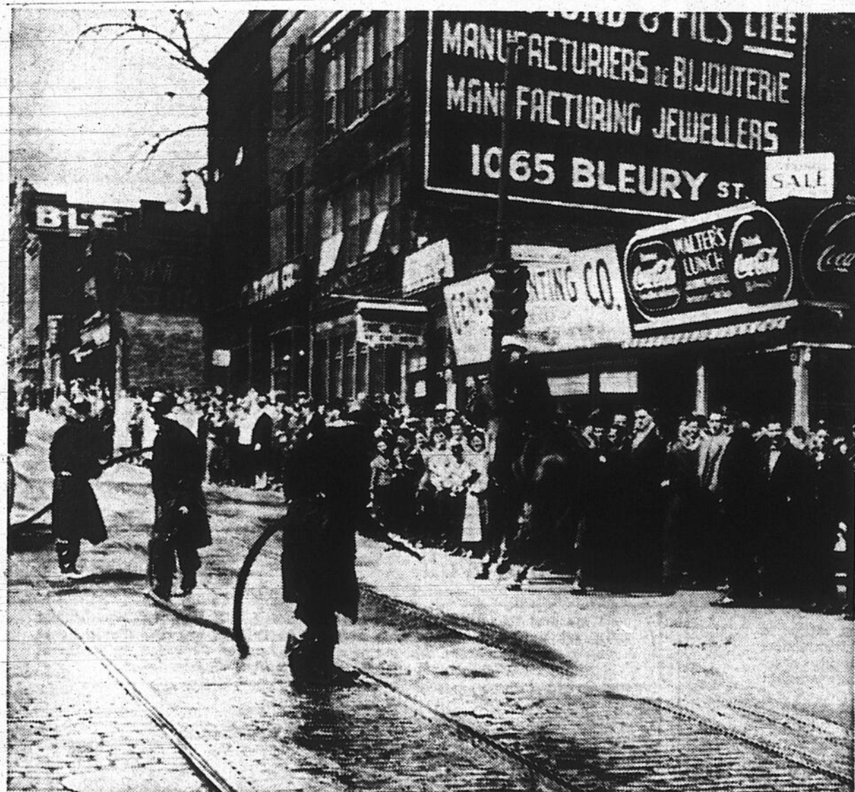
TRAGEDIE EVITEE DE JUSTESSE — On évita de justesse, hier après-midi, une explosion qui aurait pu avoir des conséquences désastreuses sans la présence d'esprit de témoins d'un accident. Un camion chargé de barils de naphte entra en collision avec un tramway, à l'angle des rues Bleury et Lagachetière. Sous le choc, un des barils tomba sur la chaussée et son contenu se répandit un peu partout. On connaît les terribles caractéristiques de ce produit. Les pompiers furent mandés d'urgence sur les lieux et lavèrent immédiatement la chaussée pour éviter tout danger d'explosion. Les voici à l'oeuvre. (Photo "Montréal-Matin", par David Bier)
