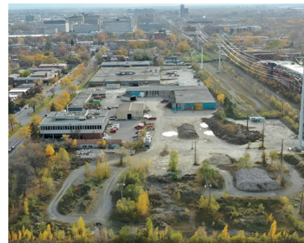
Terrain de Louvain Est, vue aérienne. (Photo : archives arrondissement Achuntsic-Cartierville)
