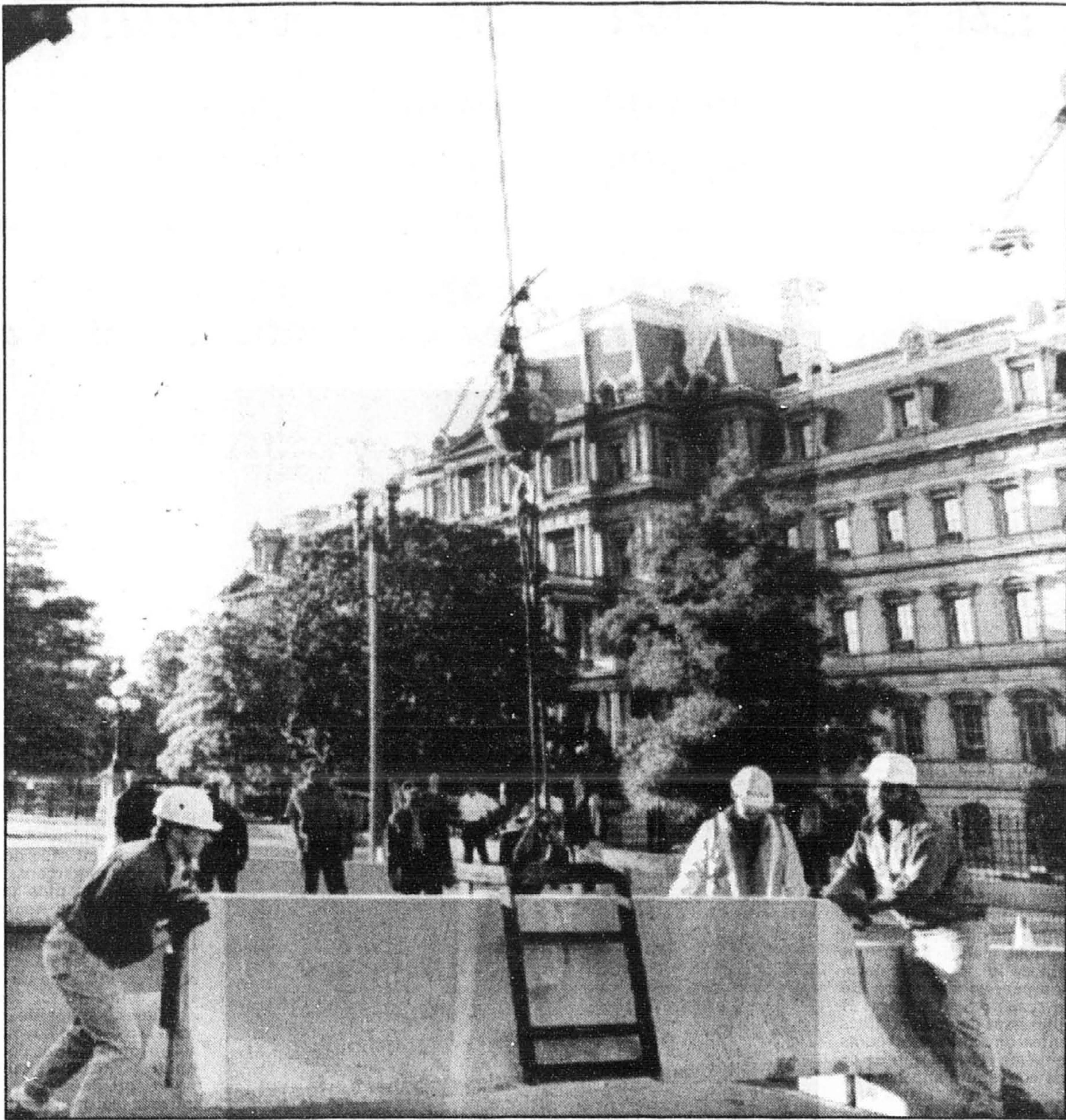
Des travailleurs complètent l'encelinte de béton qui fermera la rue Pennsylvania à la circulation automobile, à Washington, en guise de mesure de sécurité. La Maison Blanche se trouve tout à côté.
