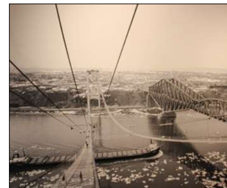
Une photo de Jules Rochon prise lors de la construction du pont Pierre-Laporte en mars 1969. Il demeure le pont suspendu ayant la travée centrale la plus longue au Canada.
