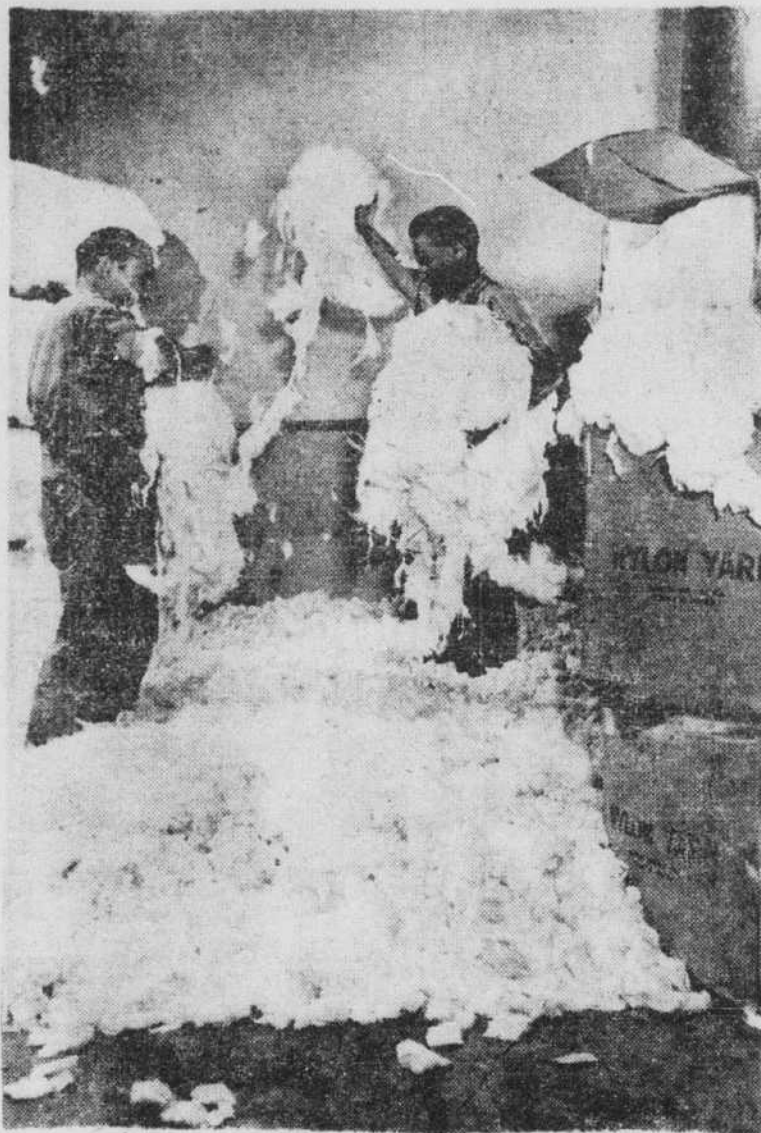
On réunit d'abord ainsi nylon et laine à des filatures comme Zephyr Textiles, Ormstown, P.Q. et Glendale Knitting Mills, Hamilton, Ont. En alternant, on répand par couches sur le parquet le nylon et la laine d'après les proportions requises dans le fil de tricot.
