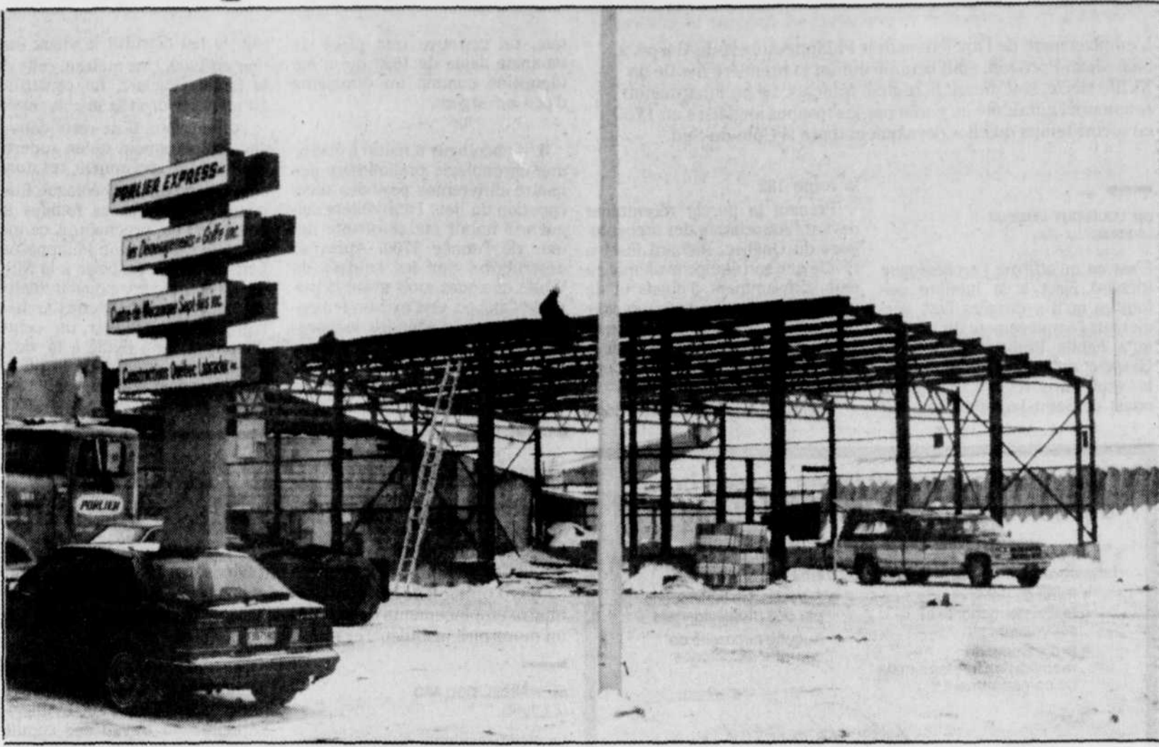
L'entreprise Porlier Express agrandit son garage de machinerie.
