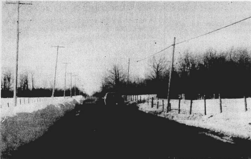
Les automobilistes qui empruntent le chemin de Planches peuvent facilement constater l'importance de la présence de pylônes dans ce secteur.
