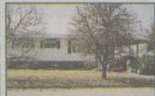
Ch2738 - Piscine creusée, air climatisé, thermopompe, sous-sol fini (possibilité de logis). Il faut visiter !! Inf. : Jean-Bruno Beaugregard
