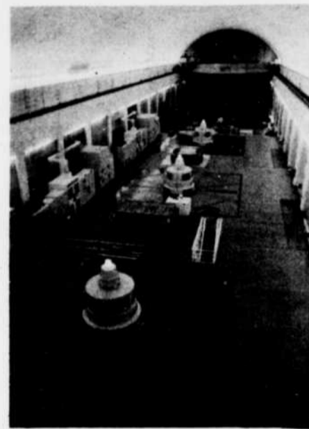
Une vue de trois groupes turbine-alternateur de Chute-des-Passes. Ce sont les roues qui actionnent ces ensembles.
