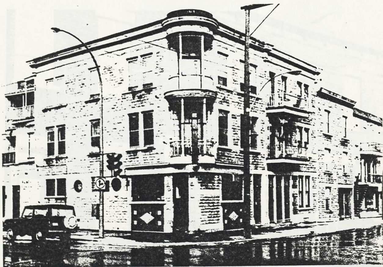
Fig. 58 Toit en terrasse, 801-811 Duluth est.
