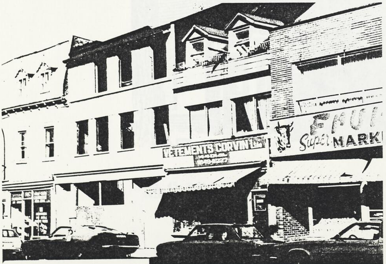
Fig. 44 Toits à pignon, 4401-4407 Saint-Laurent.
