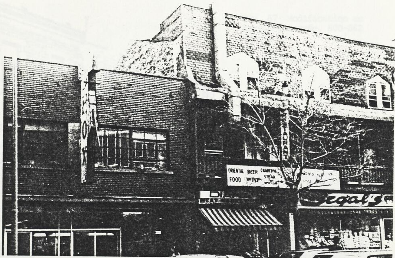
Fig. 64 Modification à la forme du toit, 4275-4299 Saint-Laurent.
