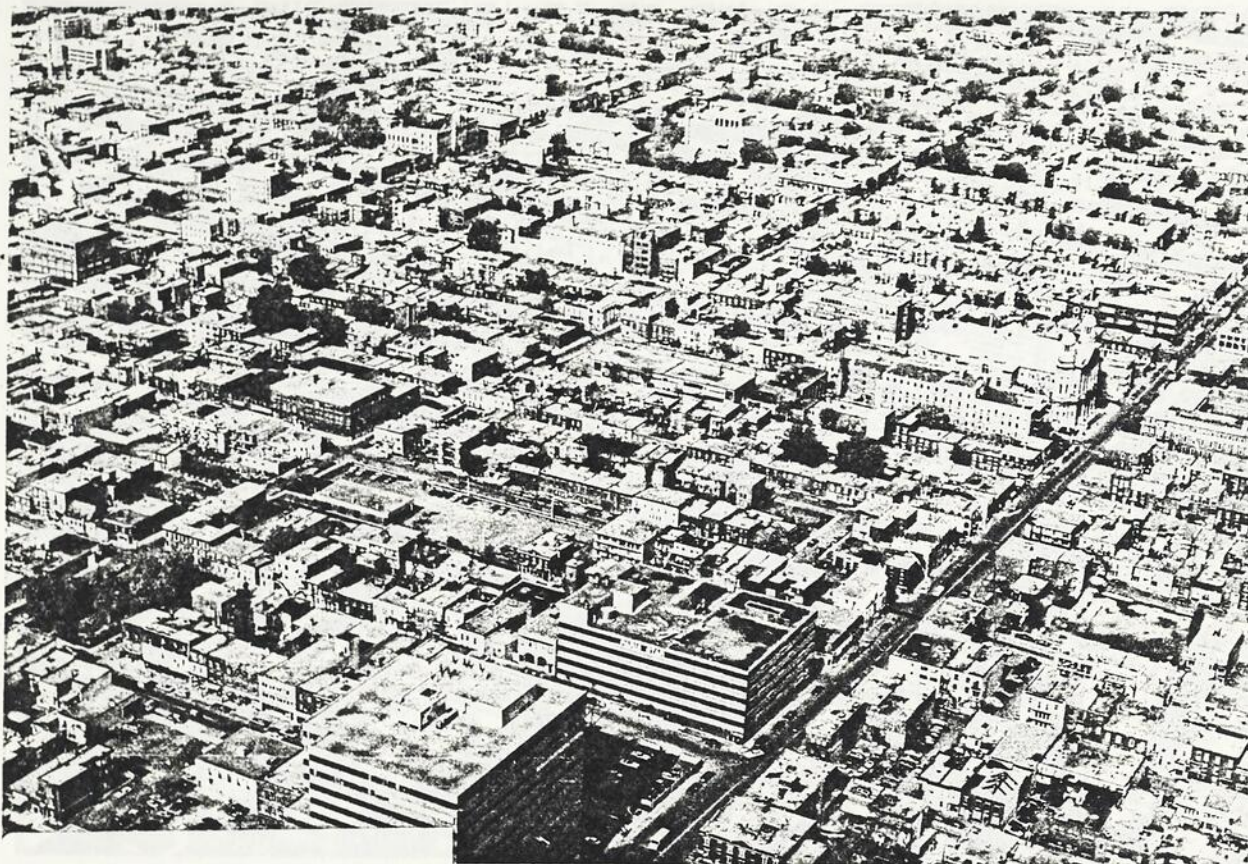
Fig. 2 Vue aérienne, secteur ouest.
