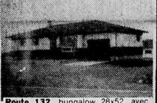
Route 132 , bungalow 28x52, avec garage. (Voisin matelas Dauphin).
