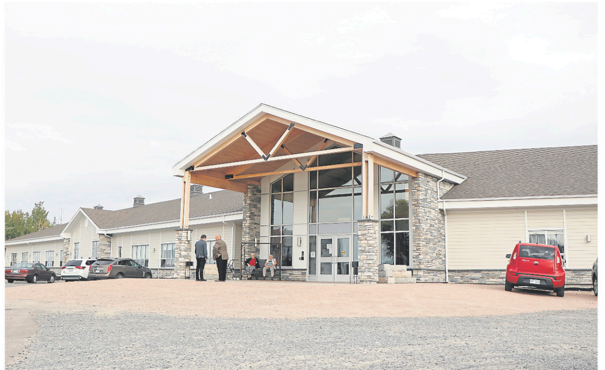
Érigée au 1845 rue Deschênes, à Arvida, derrière le Centre d'hébergement Des Chênes, la nouvelle Maison de soins palliatifs compte une douzaine de chambres afin de desservir la population du Saguenay et de la MRC du Fjord-du-Saguenay. — PHOTO LE QUOTIDIEN, SOPHIE LAVOIE
