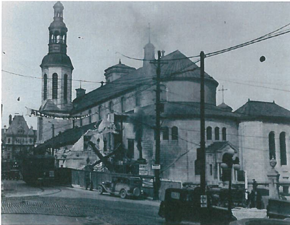
51. La démolition du presbytère et de la maison de la procure en 1931. (AVQ, A092-H1411 no 354)
