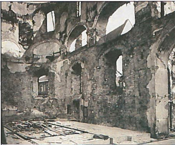
47. Le nouveau plancher du chœur en 1923. (AAQ, Photo Livernois 1923)
