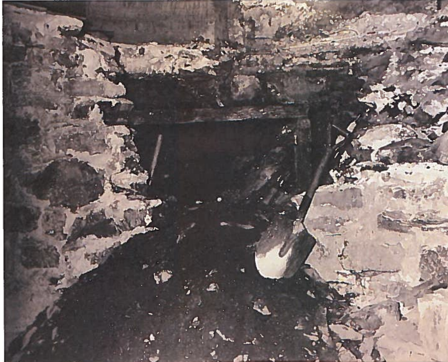
60. Le caveau fouillé en 1953. (APNDQ, Photos Raymond Thibault 1953)
