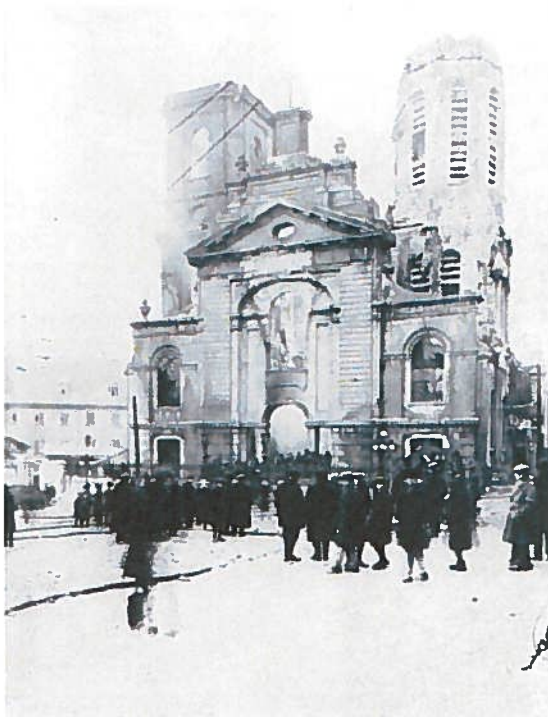
39. La basilique au lendemain de l'incendie. (BAnQ, Photo Livernois-E6,S7,P IOA)
