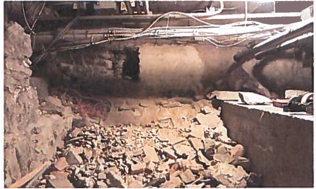
64. Accès au caveau en avril 2017.
