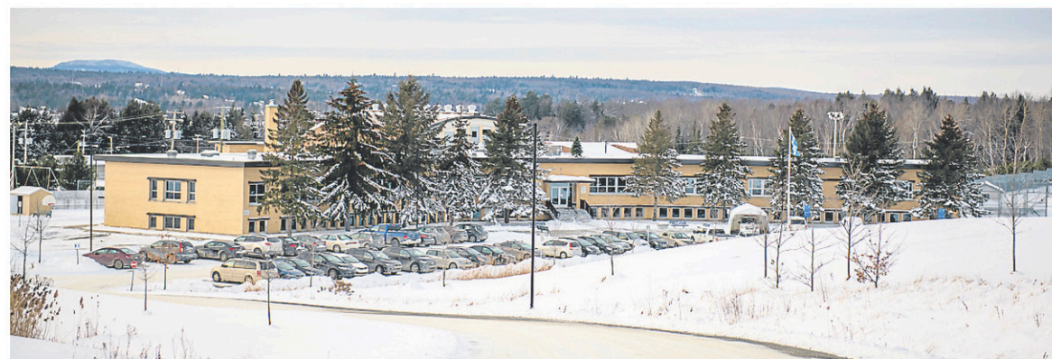
Le Centre de réadaptation pour la jeunesse Val-du-Lac souhaite faire des travaux d'environ 15 M$ pour rafraîchir plusieurs de ses pavillons dont la construction remonte aux années 1960. — PHOTO SPECTRE MÉDIA, ANDRÉ VUILLEMIN
