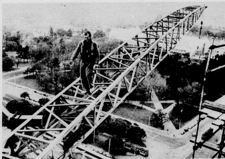
Avec d'infinies précautions, l'ouvrier Gerrit Mulder se déplace le long de la flèche d'une grue à quelque 230 pieds dans les airs, à Melbourne, en Australie. Le travail de Mulder consiste à huiler les parties mobiles de la grue qui sert à la construction d'un nouvel édifice de 19 étages.
