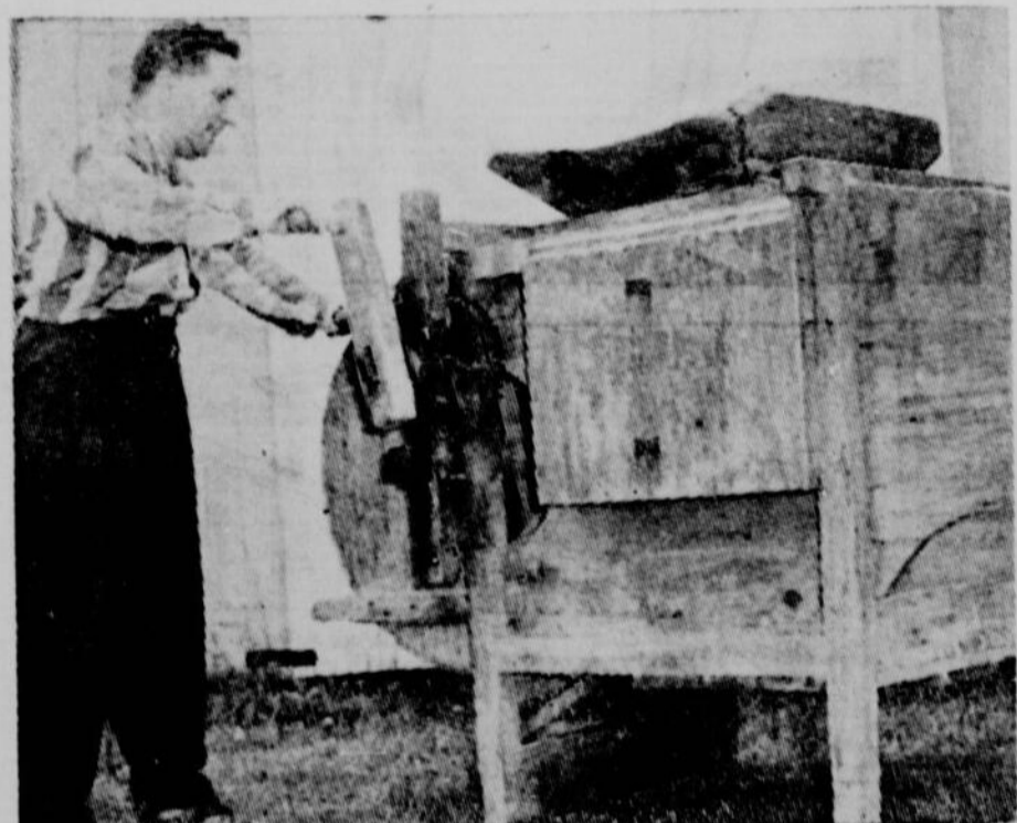
Un autre instrument aratoire disparu depuis longtemps sur nos fermes... Ce crible à manivelle était pourtant d'usage courant dans nos campagnes vers les 1800.
