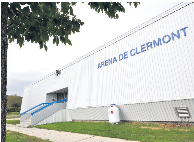
La toiture de l'aréna sera refaite
