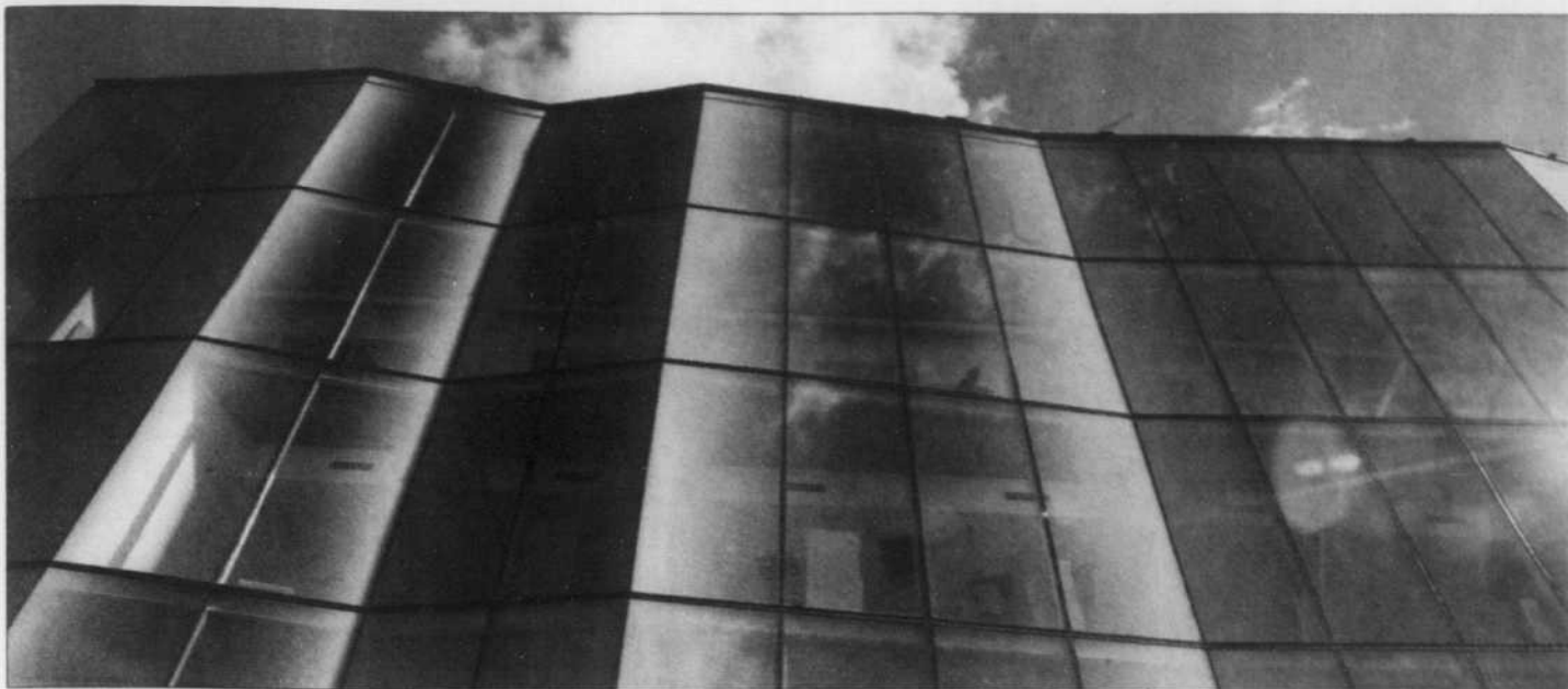
Détail du pavillon Pierre-Dansereau du Complexe des sciences de l'UQAM.
