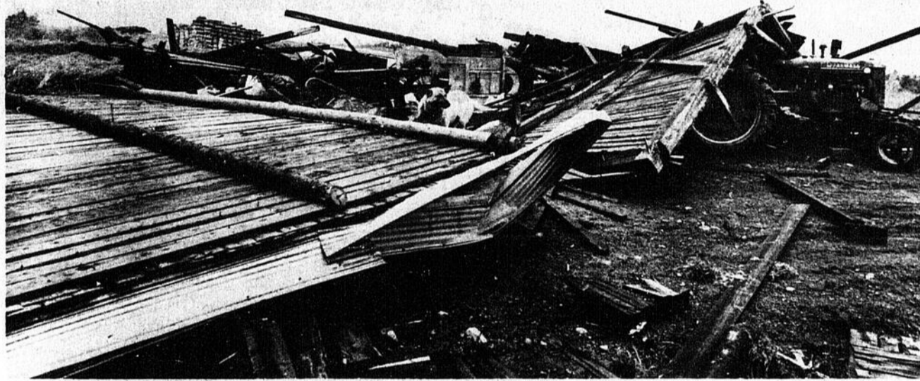
OURAGAN — Cette grange, dans le secteur de Desbiens, s'est écroulée, hier, lors de la tornade.
