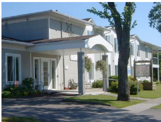
Photo Maison d'un Nouvel Élan
