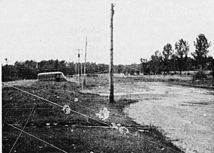
Vue générale d'une partie du futur Domaine Dumond. Plus de 25 maisons seront mises en chantier cet automne.
