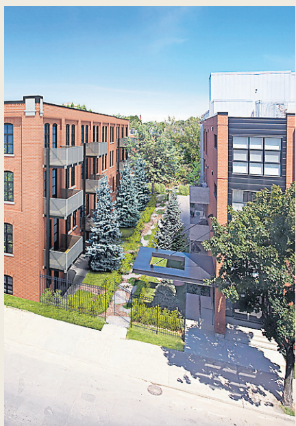
PHOTO FOURNIE PAR JEAN LACHAPPELLE La phase 2 de Loft GenX (à gauche sur l'image) s'insère dans une ancienne usine de chaussures. La phase 1 (à droite), déjà complétée, se trouve dans une bâtisse neuve.
