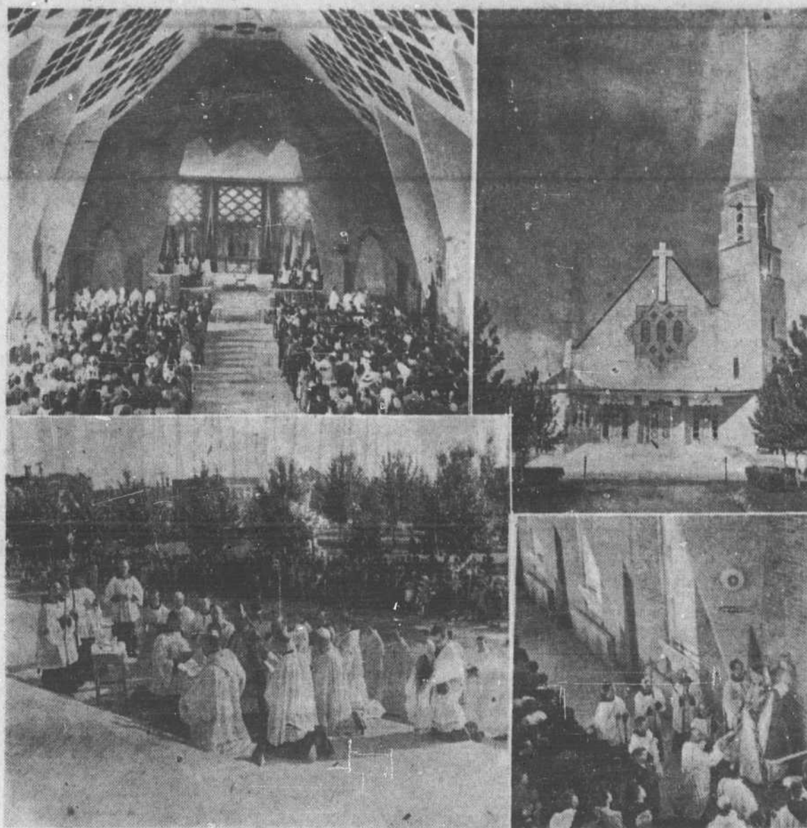
CONSECRATION DE L'EGLISE DE DOLBEAU: La consécration de l'église paroissiale de Dolbeau a donné lieu à des fêtes inoubliables dimanche. La photo du haut, à gauche, donne une vue de l'intérieur du temple, au cours de la cérémonie, et de la foule en prière. A droite, une vue de l'extérieur de l'église consacrée. La photo du bas, à gauche, fait voir S. Exc. Mgr GEORGES MELANCON, évêque de Chicoutimi, qui préside la cérémonie de consécration. Cette scène fut croquée au début de la cérémonie, avant l'entrée du clergé dans le temple. En bas, à droite, S. Exc. Mgr Melancon fixe au mur l'une des deux petites croix qui ornent l'église consacrée. Le temple de Dolbeau est la première église paroissiale à être consacrée dans le diocèse de Chicoutimi. C'est un fait véritablement digne de mention qui fait honneur aux généreux paroissiens de Dolbeau.
