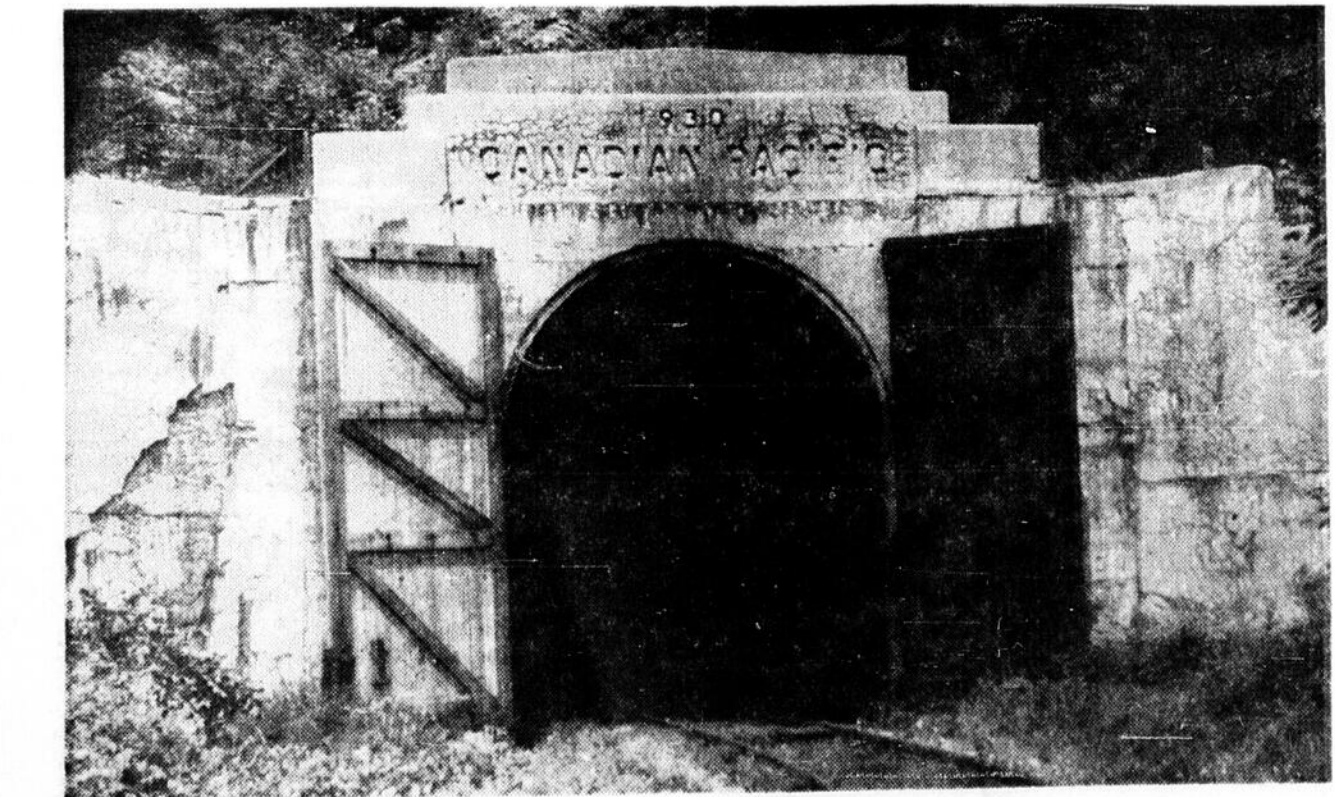
L'extrémité est du tunnel, au pied de la côte Guilmour, à l'Anse-au-Foulon
