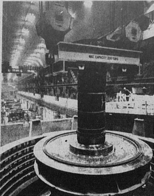
COOPÉRATION TECHNIQUE FRANCO-QUÉBÉCOISE CHEZ MARINE INDUSTRIE DE SOREL. Avec l'aide technique des sociétés françaises Alsthom et Neyrpic, Marine Industrie, de Sorel, construit des turbines, des alternateurs et des compensateurs synchrone de grande puissance. Le ministère des Affaires intergouvernementales du Québec contribue à ce projet en facilitant les échanges de techniciens entre les deux sociétés. Nous voyons (en haut, à gauche) le premier rotor d'alternateur de l'un des huit groupes de 170 MV A que Marine Industrie a construit pour le barrage de Manic 5. La photo du bas nous fait voir la roue Francis, un des 5 groupes de 648 000 H.P., 500 MVA que Marine Industrie construit pour l'usine souterraine de Churchill Falls. Enfin, à droite nous voyons un des quatre compensateurs de 250 MVAR 900 tr-mn, construit à Sorel pour l'Hydro-Québec.
