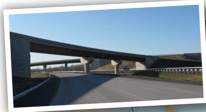
L'échangeur 30/730 est terminé depuis octobre 2009. Il comprend trois ponts d'élevage ainsi que trois bretelles.
