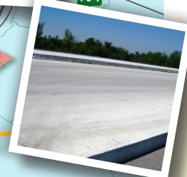
Dalles de béton de l'autoroute 30 situées entre la rue Saint-François-Xavier et l'autoroute 15. La chaussée de la partie Est de l'autoroute 30 sera entièrement construite en béton.
