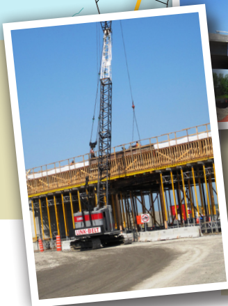
Pont de l'autoroute 30 passant au-dessus de la rivière de la Tortue, de la montée de la Saline et du rang Saint-Ignace. Il reste des travaux de finition à effectuer, notamment la pose des glissières de sécurité, l'asphaltage et les dalles d'approche.
