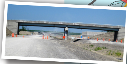
Pont d'élevage du rang Saint-Régis Sud enjambant l'autoroute 30. Ce pont d'élevage est terminé tout comme celui du rang Saint-Régis Nord.
