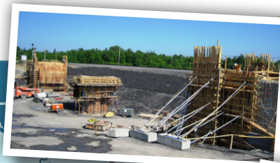
Construction des culées et de la pile du pont d'élevage ferroviaire du Canadien Pacifique. L'autoroute 30, qui sera à cet endroit en dépression, passera sous le pont.
