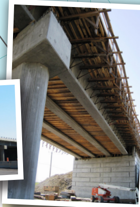
Des travaux de coffrage de dalles sont en cours au pont d'élevage du chemin Saint-François-Xavier. Celui-ci devrait être terminé à la fin du mois de juin.
