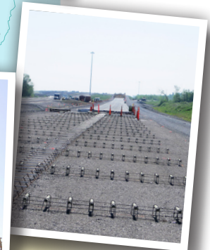
Préparation pour la mise en place du béton des dalles de chaussées entre la rue Saint-François-Xavier et l'autoroute 15.
