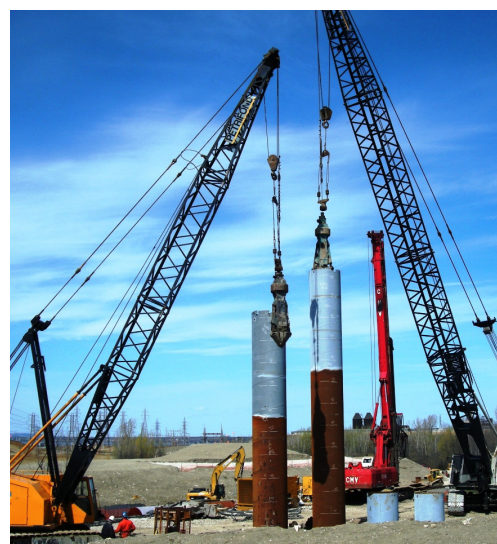
Installation de pieux à l'axe 1 du pont d'étagement de la route 236 qui passera au-dessus de la voie ferrée de CSX.
