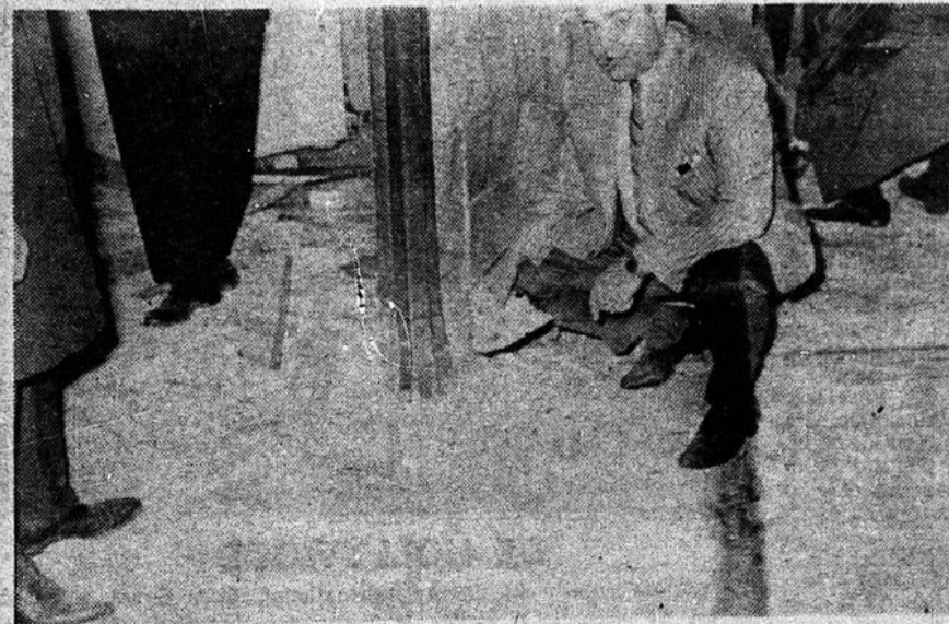
Le sergent-détective Jean Tétréault indique le trou causé dans le plancher de béton par l'explosion de la bombe placée à cet endroit.
