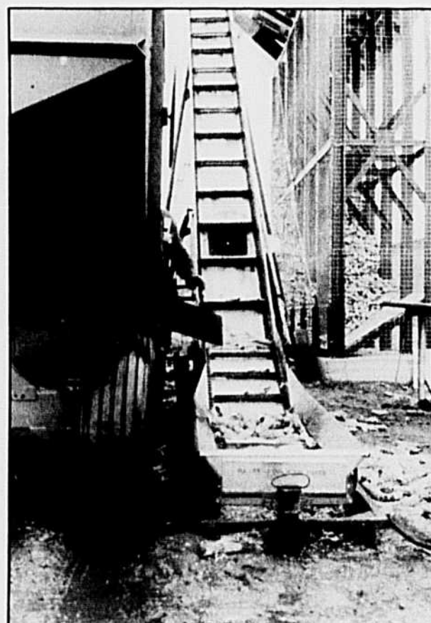
Remplissage du crib avec la voiture basculante et l'élevateur modifié.
