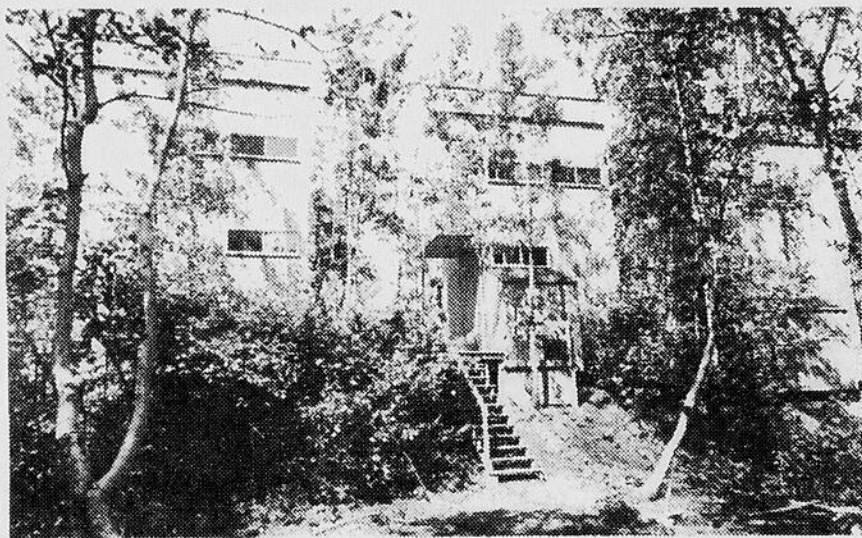
GRAND LARGUE — Des chalets identiques à ceux-ci vont être bientôt construits.
