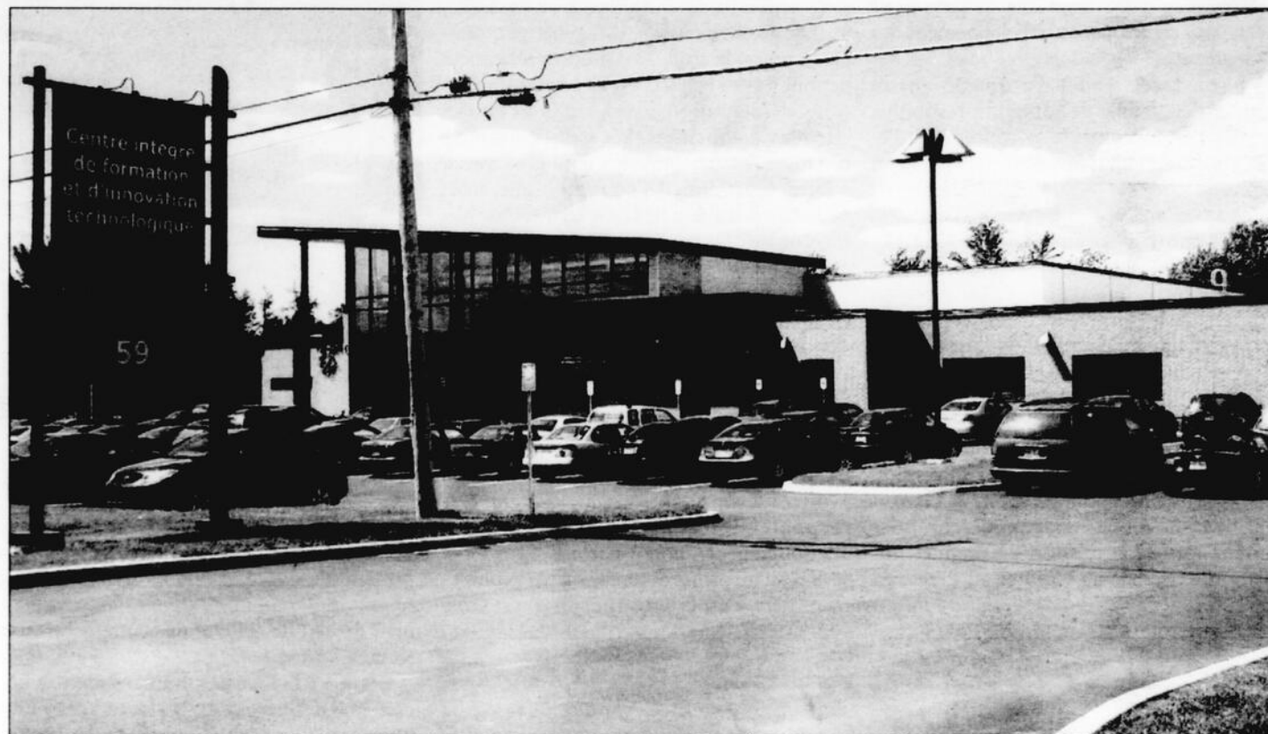
L'agrandissement du CIFIT est prévu depuis sa construction, en 2006.
