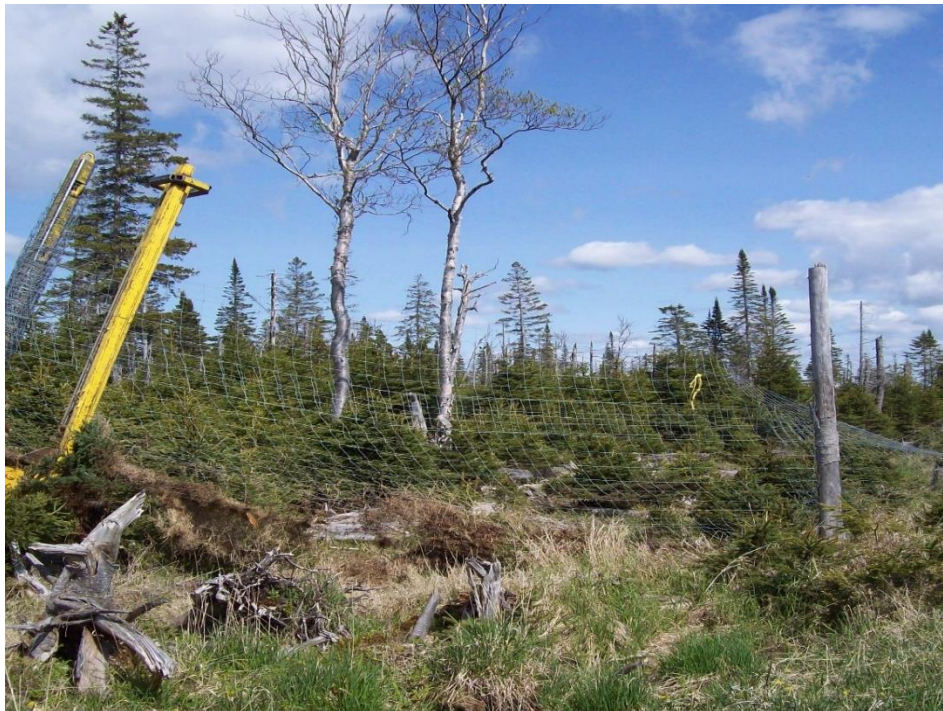
FIGURE 3 : ENROULEMENT DE LA CLÔTURE DÉMANTELÉE
