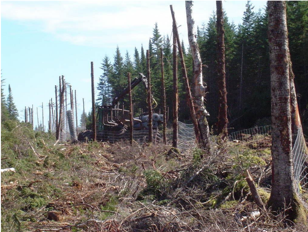
FIGURE 1 : INSTALLATION DE LA CLÔTURE À L'AIDE D'UN PORTEUR FORESTIER
