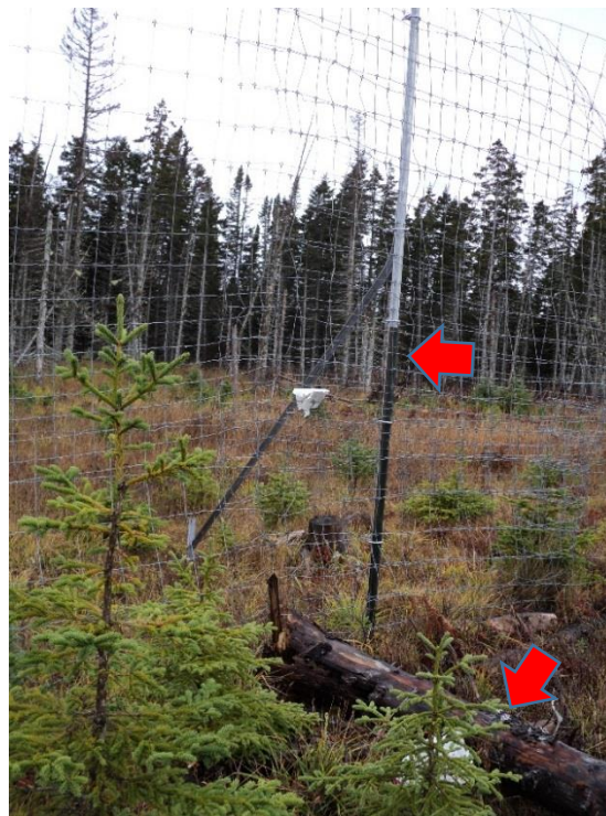
FIGURE 5 : REMPLACEMENT D'UN POTEAU EN BOIS TOMBÉ PAR UN POTEAU DE MÉTAL
