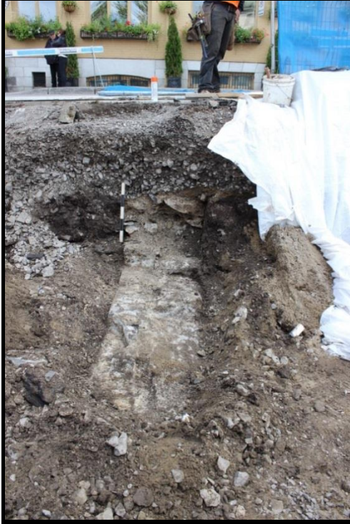
Photo 3 : Vue vers le sud du mur de fondation (10A100), situé à l'angle des rues Sainte-Anne et des Jardins (Photo : Manon Goyette, CeEt-35-2013-NUM-01).
