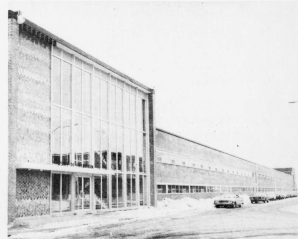
L'usine de filtration de Jacques-Cartier (Photo Charpentier)
