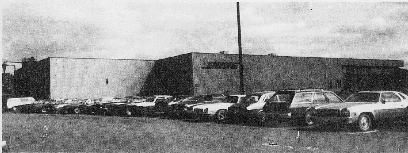
Les installations de l'entreprise Bose Canada, dans le parc industriel de Ste-Marie.
