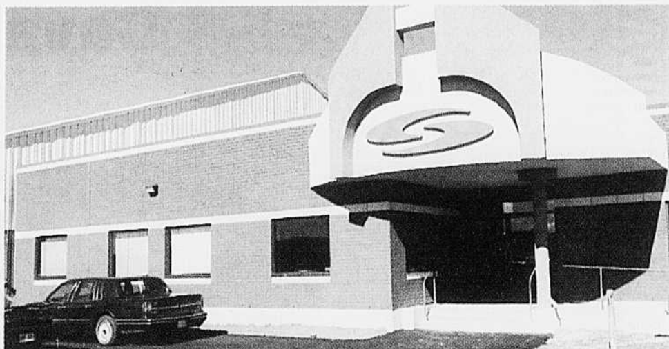
La façade du Sani Sport a été complètement transformée (photo: Robert Gosselin/PPM)
