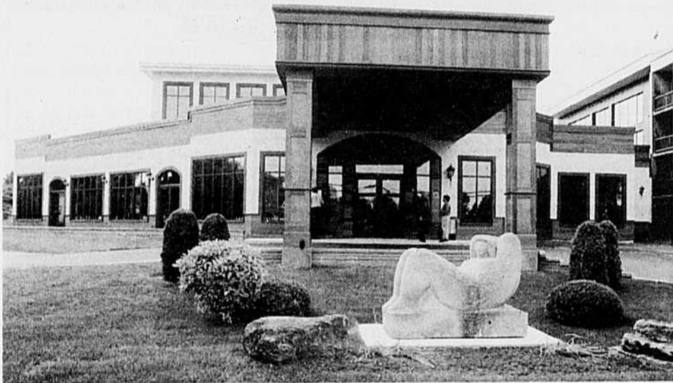
Le coup d'œil de l'entrée de la nouvelle Hostellerie Rive-Gauche est impressionnant.
