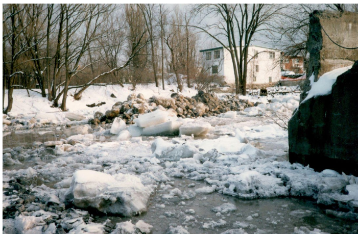
Ci-dessus : Travaux de restauration du Site des moulins à la fin des années 1990.
