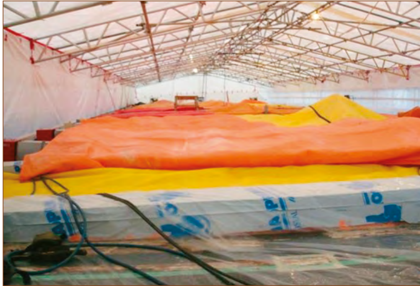
Figure 24 Utilisation de couvertures chauffantes pour favoriser le séchage des éléments de toiture lorsque les conditions ambiantes ne sont pas favorables (source : Wang, 2020).
