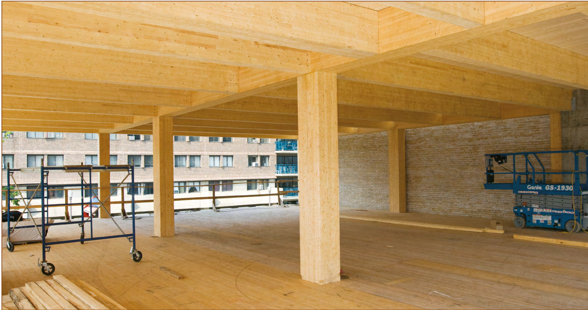
Figure 7 Assemblages et attaches métalliques recouverts de bois avant encapsulation
