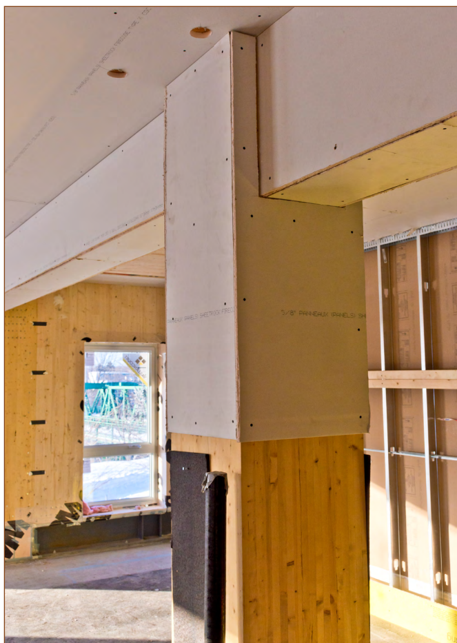
Figure 12 Installation de la première couche d'encapsulation (source : J.-F. Grandmont, 2017)
