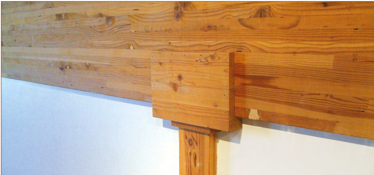
Figure 7 Assemblages et attaches métalliques recouverts de bois avant encapsulation
