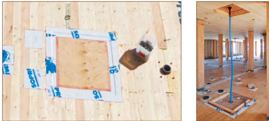
Figure 29 Protection des ouvertures lors de la construction (source : GHL Consultants Ltd.)
