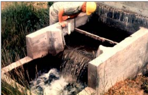
Figure 24. Déversoir trapézoïdal
