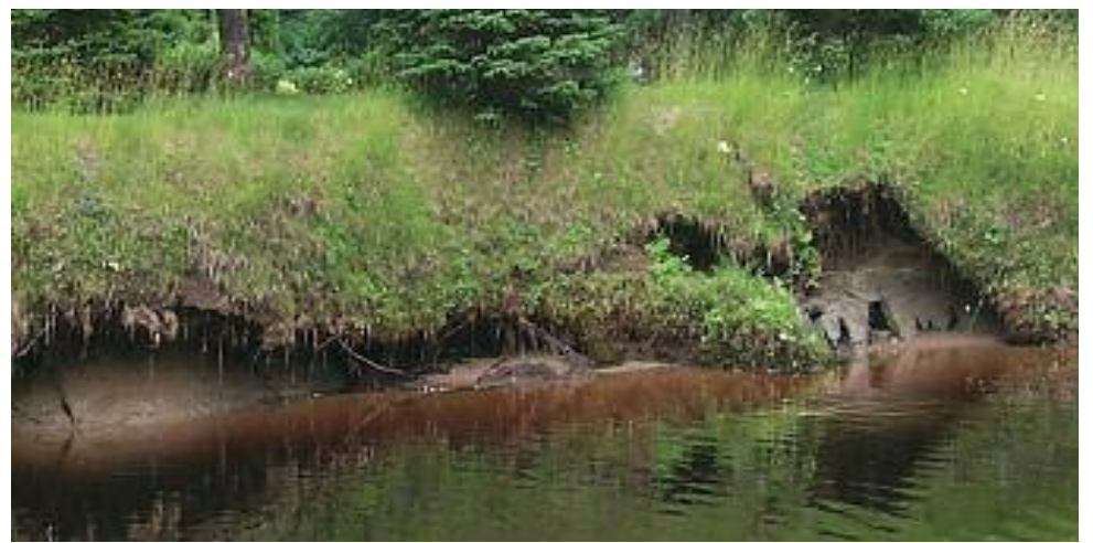
Érosion causée par le battement des vagues sur la rive.
