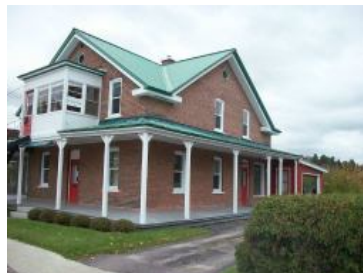
James Scott pour la maison construite par Isidore Gauthier
