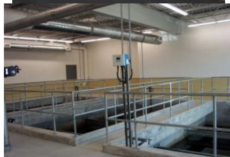
Usine d'eau potable du Grand-Lièvre Mont-Laurier Source : Ville de Mont-Laurier
