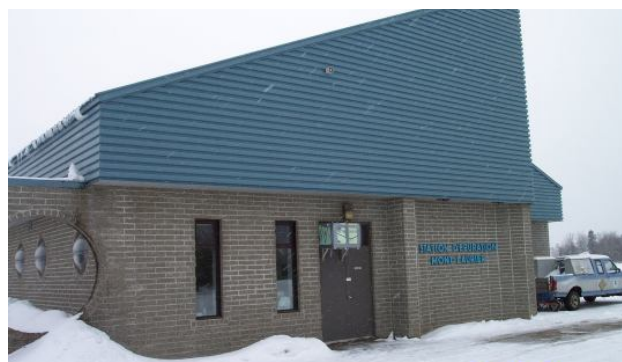
Usine d'épuration des eaux usées Source : Ville de Mont-Laurier
