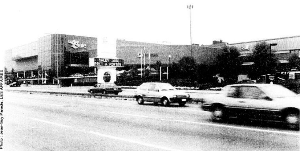
La Place Belle-Cour bénéficie de l'achalandage généré par la Place Laurier (photo).
