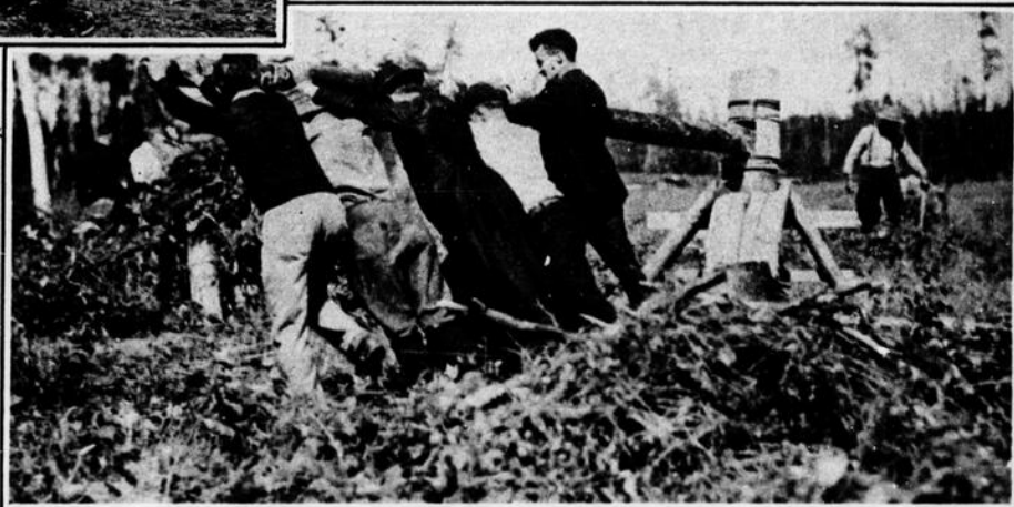
L'essouchage au moyen d'un cabestan de confection domestique à St-Augustin-de-Montbeillard, nouveau Témiscamingue.
