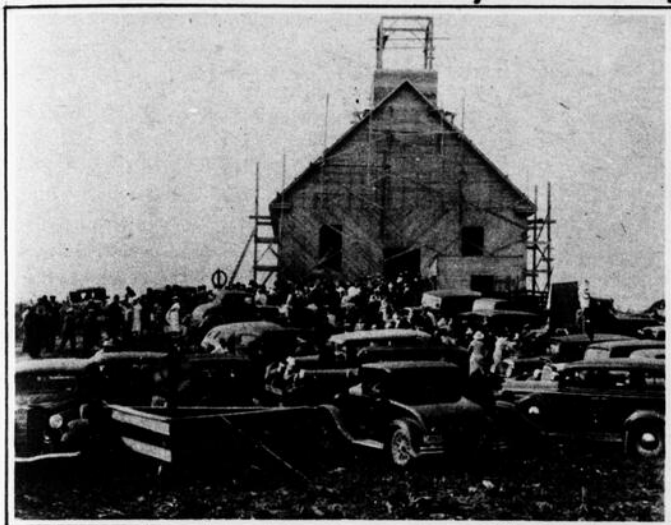
La nouvelle église de Ste-Monique-de-Rollet en construction.-Témiscamingue.
