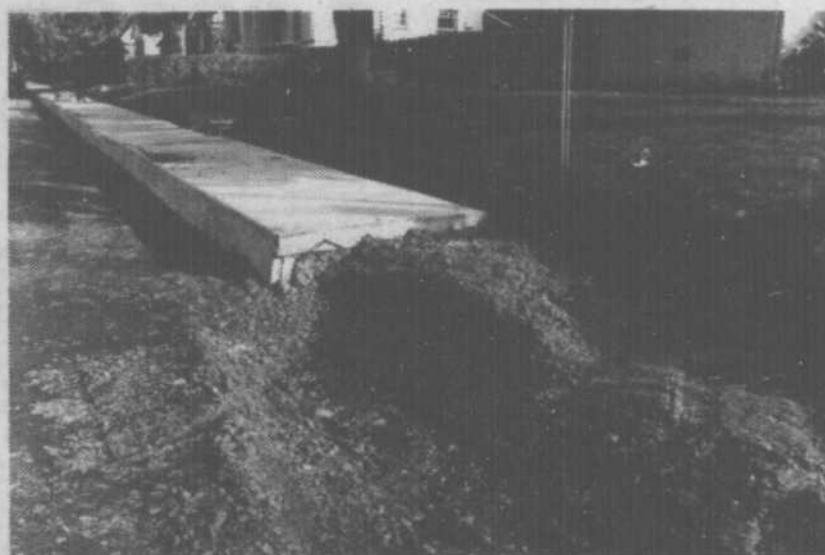
LA RÉFECTION DES TROTTOIRS: Nous apercevons ici (rue Labonté, angle Lemoyne) un tronçon de trottoir terminé, avec quelques tiges d'armature qui ont, par la suite, servi à bien relier le béton frais au segment déjà sec. On peut observer aussi l'excavation. La coupe dans le sol qui permet ensuite la pose des formes.
