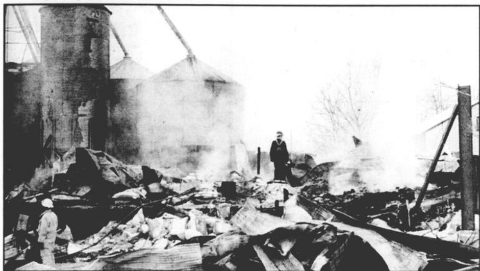
Ce n'est que vers sept heures que l'incendie a été mis sous contrôle. Un peu plus tard en matinée, des sapeurs de Fort Covington ont été appelés à retourner sur le site du sinistre puisque de la fumée émergeait encore des ruines des bâtiments. (photo P.L.)
