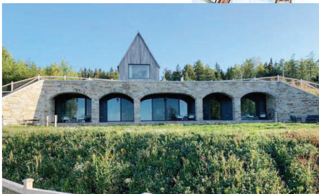
La façade extérieure des Arches. Photo Agence Bix
